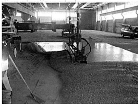
Рис. 2.26. Разравнивание и уплотнение уложенного фибробетона при помощи лазерного бетоноукладчика [13]
