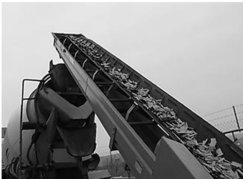
Рис. 2.6. Введение фибры в бетон по конвейерной ленте [7]
