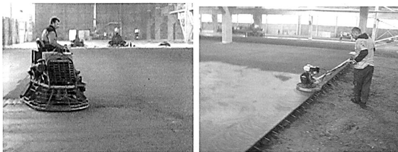
Рис. 2.28. Затирка поверхности плиты бетоноотделочной машиной [16]: а – затирка поверхности пола двухроторной бетоноотделочной машиной; б – затирка поверхности пола однороторной бетоноотделочной машиной
