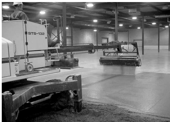
Рис. 2.27. Нанесение топпинга машиной Topping spreader [13]
