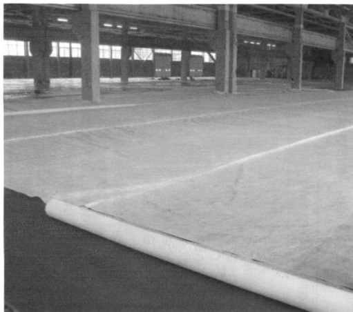
Рис. 2.29. Уложенный геотекстиль на поверхность бетона [16]
