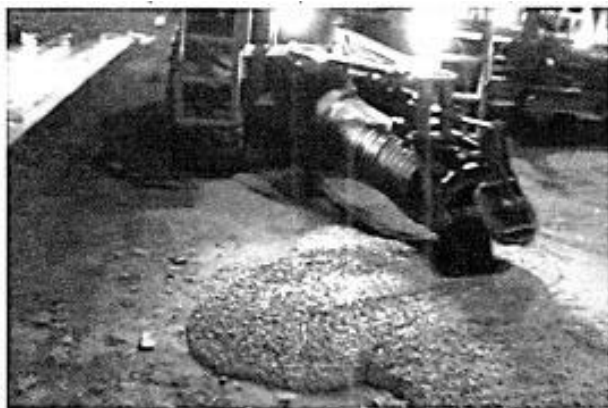
Рис. 2.25. Укладка фибробетона автоматическим бетононасосом [13]
