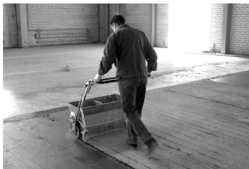
Рис. 2.17. Рассыпка топпинга тележкой [15]
