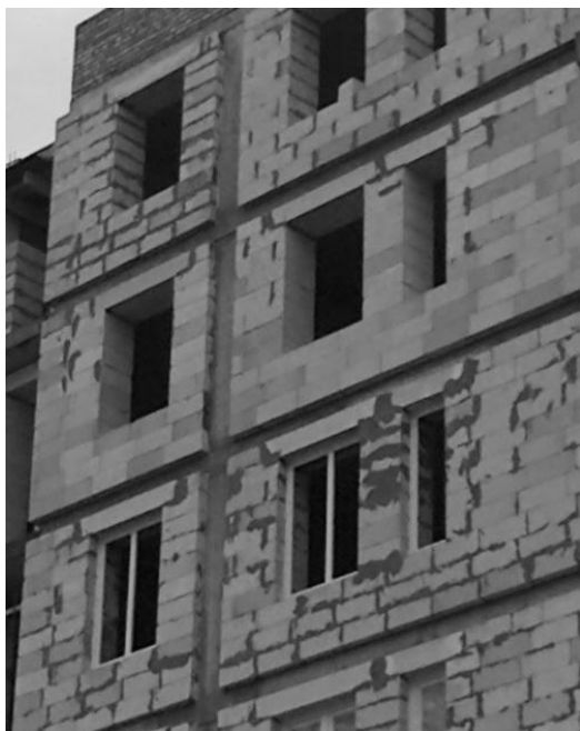
Рис. 1 – Строящийся дом со стенами с консольными выступами
