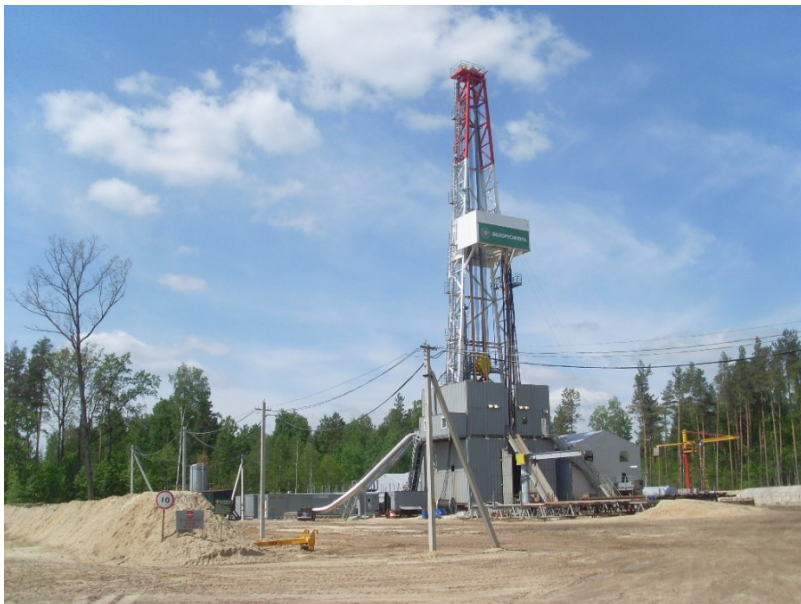
Рис. 1. Общий вид буровой установки Ventec
