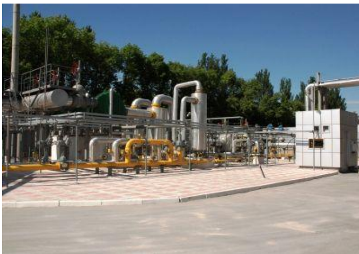
Рис. 1. Система смешивания газа КГЭС шахты Засядько
