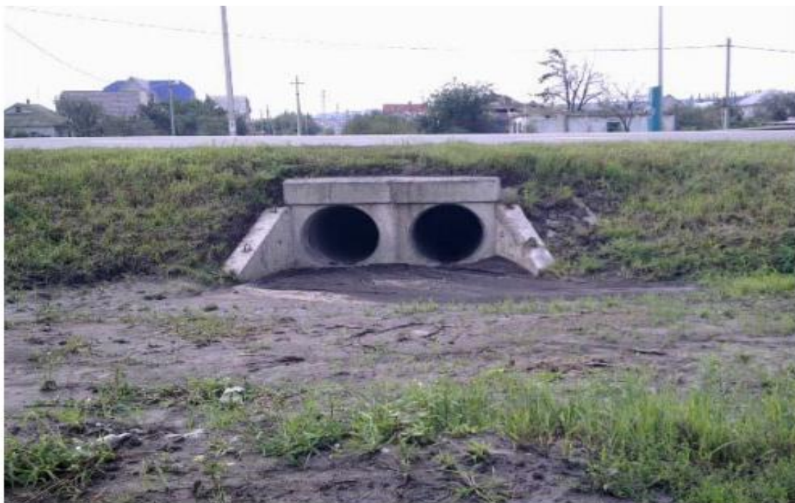
Рисунок 3 – Двухочковая круглая железобетонная труба
