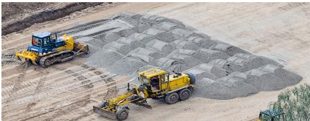
Рис. 1 Схема отсыпки дренирующего слоя дорожной одежды
