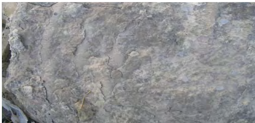
Рис. 3. Структура грунтоцемента при двухкратной проходке, скорости вращения инструмента 85 об/мин., скорости осевого перемещения 0,5 м/мин
