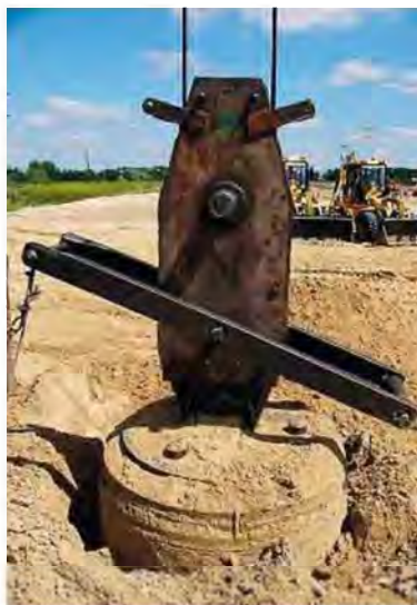
Рис. 3. Формирование вытрамбовываемого столба
