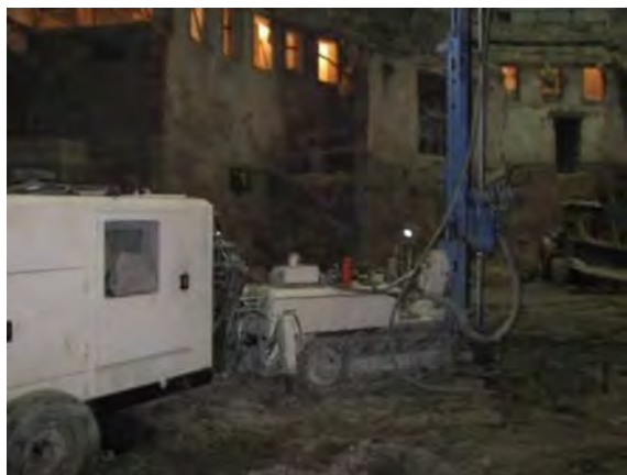
Рис. 2. Устройство противофильтрационной ванны установкой «Jet Grouting» при реконструкции здания цирка.
