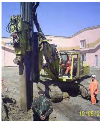
Рис. 1. Проходка скважин для буронабивных свай: а – погружением конического пуансона подвесным вибратором; б – погружением обсадной трубы вибратором на жесткой направляющей станка АВИ
