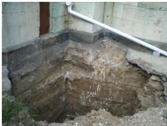
Рис. 5. Фундамент Собора Святого Равноапостольного князя Владимира, г. Севастополь
