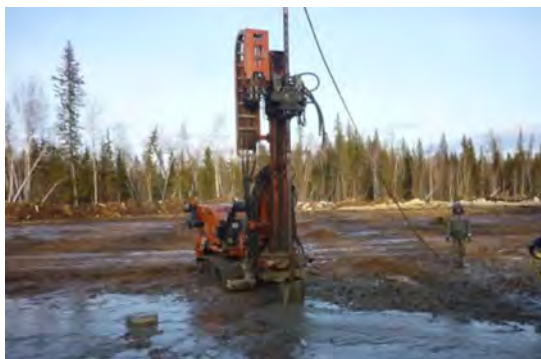
Рис. 5. Производство работ по технологии струйной цементации грунтов
