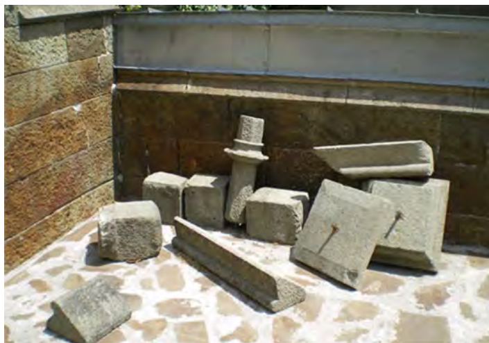
Рис. 2. Последствия землетрясения 1927 г. Воронцовский дворец, п.г.т. Алушка
