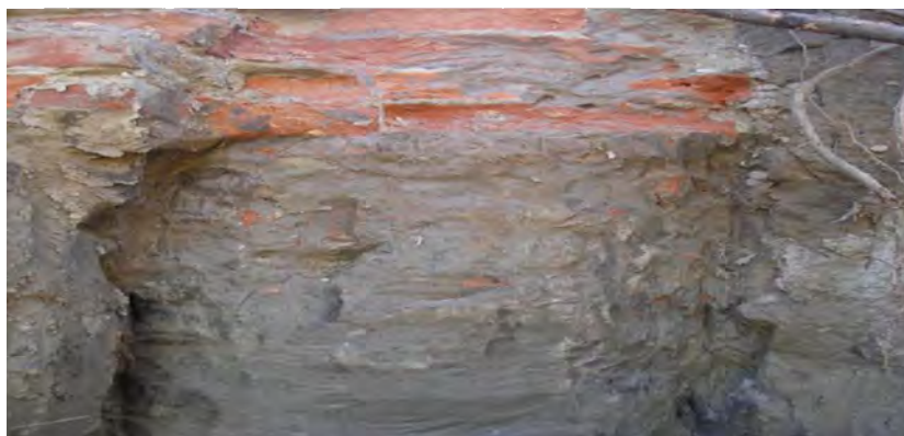
Рис. 4. Грунтоцементный элемент с включением фрагмента кирпичного фундамента
