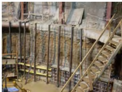
Рис. 5. Выполнение внутри ванны гидроизоляции и облицовки
