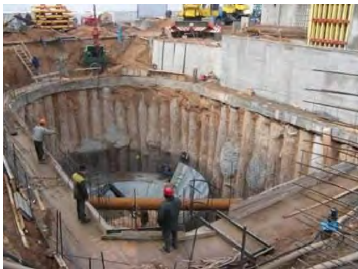
Рис. 11. Ограждение котлована из буронабивных свай диаметром 1,0 м на БАЗ в г. Жлобине
