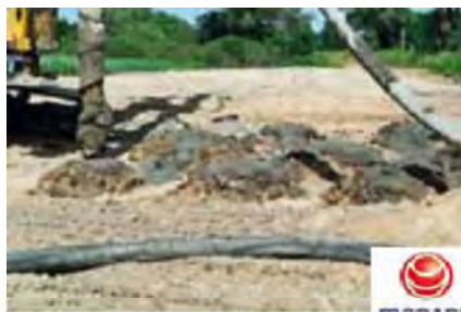
Рис. 6. Выполнение бетонных столбов с оголовками бетонно-гравийными, исполнитель: ООО Менард, Польша
