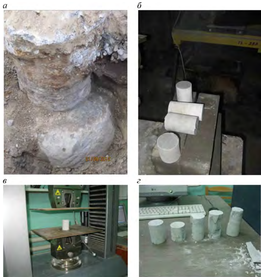
Рис. 13. Исследование свай на объекте: а – откопанная свая и уширение; б – керны, выбуренные из уширения; в – испытания кернов; г – испытанные образцы
