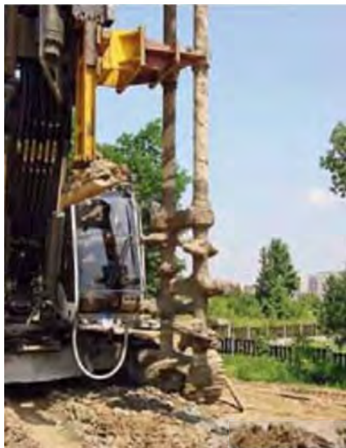
Рис. 2. Выполнение столбов по технологии DSM двойным смесителем, исполнитель: ООО Куллер Польша
