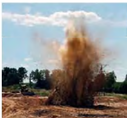
Рис. 7. Упрочнение основания методом микровзрывов, исполнитель: ООО Олбуд-Поморже
