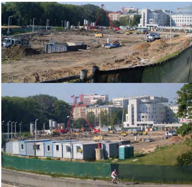
Рис. 8. Строительные работы на котловане для многофункционального комплекса «Кемпински»
