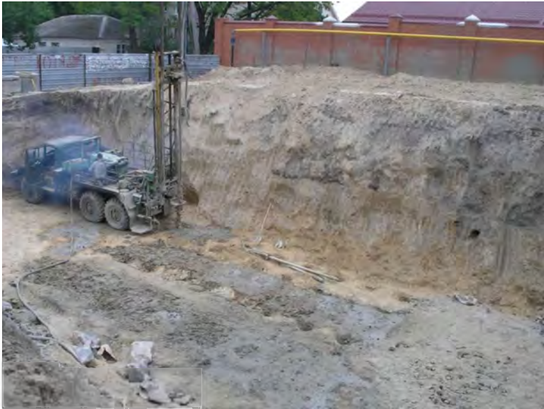
Рис. 7. Выполнение работ по закреплению просадочных грунтов
