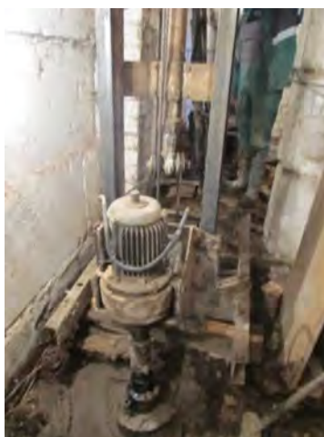
Рис. 3. Бурение скважины малогабаритным буровым станком с электрическим приводом
