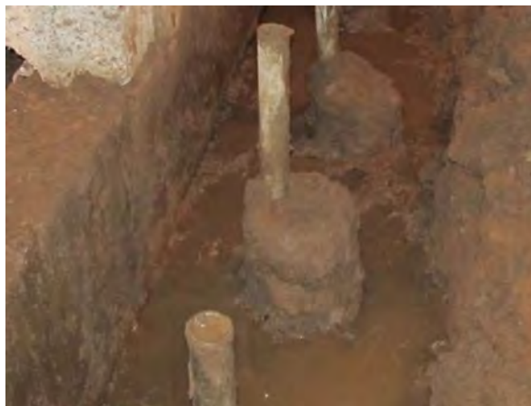
Рис. 4. Общий вид винтовых свай после откопки
