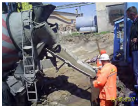
Рис. 2. Бетонирование ствола сваи в обсадной трубе из миксера
