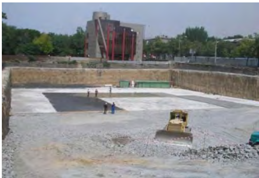
Рис. 5. Общий вид котлована, борта которого закреплены ГЦЭ.
