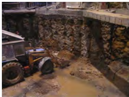
Рис. 4. Раскопка котлована внутри ванны и протечки в нее воды
