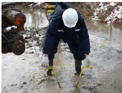
Рис. 6. Измерение диаметра грунтоцементной колонны
