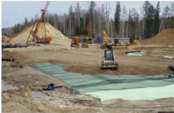
Рис. 8. Устройство гибкого ростверка
