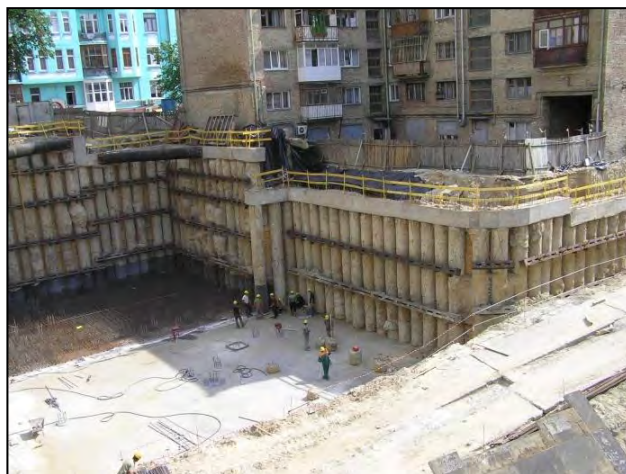
Рис. 11. Конструкция котлована. Вид на дом А – Саксаганского 70/16
