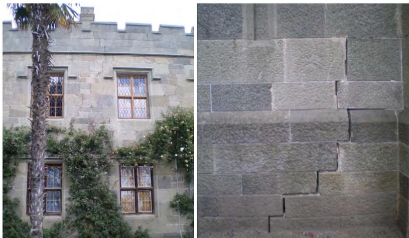
Рис. 3. Последствия неравномерных осадок фундаментов вследствие искусственного обводнения грунтов.
