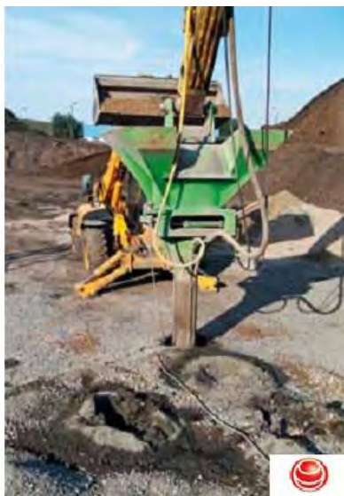
Рис. 5. Заполнение трубы, образуя агрегаты гравия колонны ноги (объезд Елку), источник: ООО Менард, Польша
