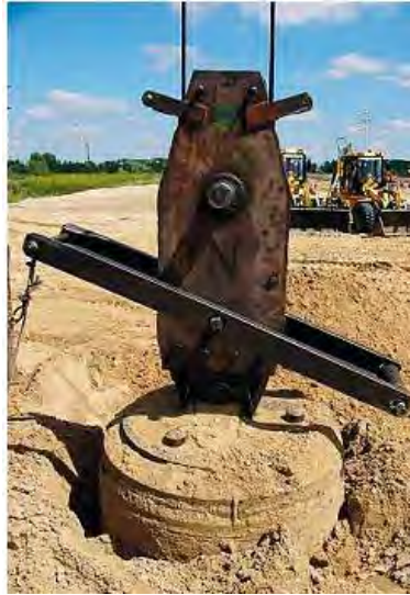
Рис. 3. Формирование вытрамбовываемого столба
