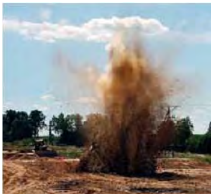
Рис. 7. Упрочнение основания методом микровзрывов, исполнитель: ООО Олбуд-Поморже
