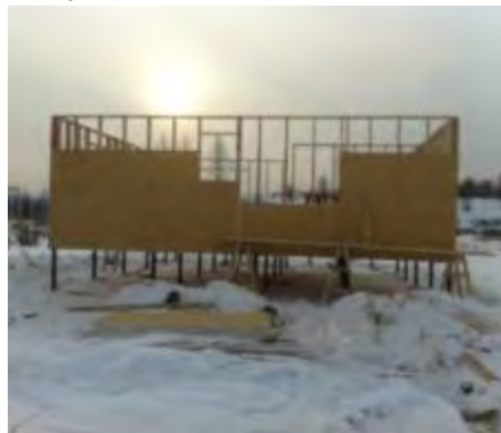
Рис. 1. Разработанные варианты свай СВ по ТУ ВУ 191301472.003-2012 (а) и примеры возведения объектов с их использованием (б), (в): б – щитовой дом на сваях СВ в процессе возведения; в – конвейер для подачи труб в пескоструйный цех
