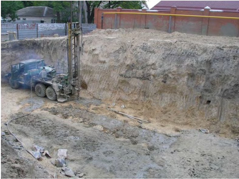
Рис. 7. Выполнение работ по закреплению просадочных грунтов
