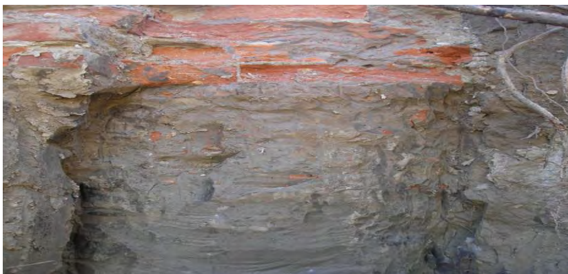
Рис. 4. Грунтоцементный элемент с включением фрагмента кирпичного фундамента
