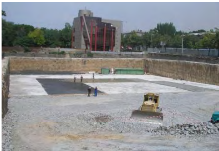
Рис. 5. Общий вид котлована, борта которого закреплены ГЦЭ.
