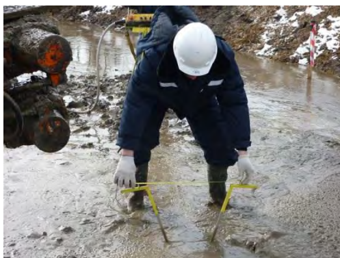
Рис. 6. Измерение диаметра грунтоцементной колонны
