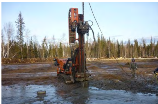
Рис. 5. Производство работ по технологии струйной цементации грунтов
