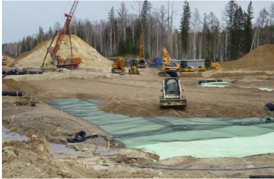
Рис. 8. Устройство гибкого ростверка
