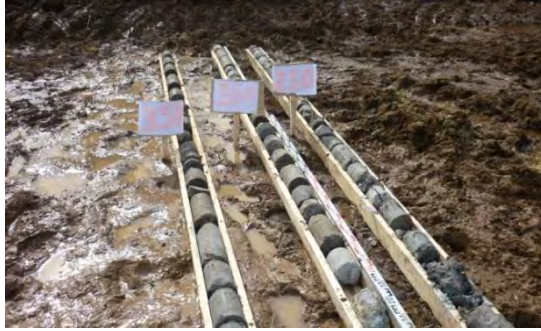
Рис. 7. Керны, выбуренные из тела грунтоцементной колонны
