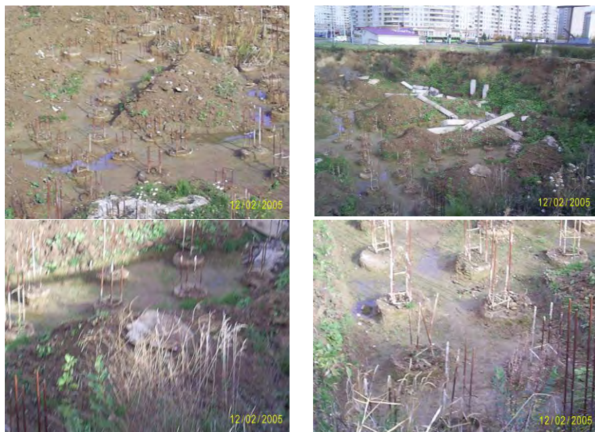
Рис. 3. Затопление котлована с неспланированной поверхностью дна при устройстве конических выштампованных буронабивных свай
