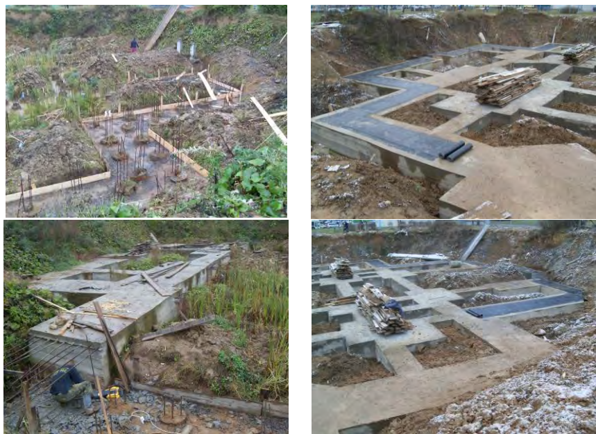
Рис. 4. Устройство бетонной подготовки и ростверков с горизонтальной гидроизоляцией после осушения котлована
