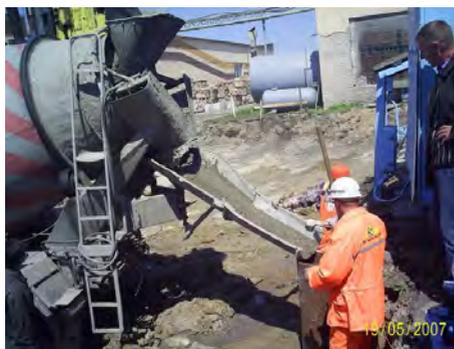
Рис. 2. Бетонирование ствола сваи
