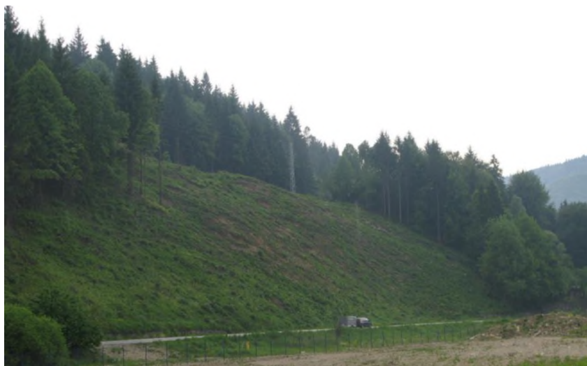
Рис. 1: Откос восточного портала тоннеля Ройков
