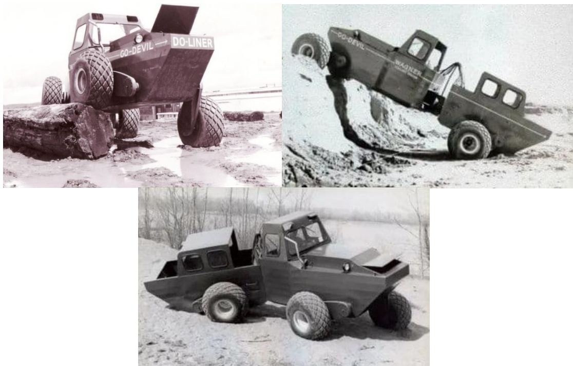
Рис. 1. Колесно-шагающий движитель типа «Го-девилль».
