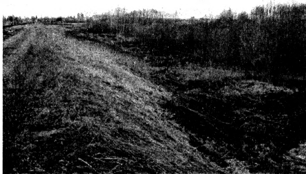
Рис. 1. Насыпь и прилегающая территория
