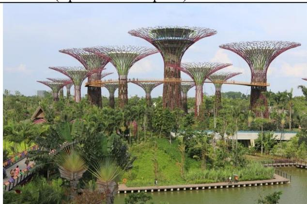
Рисунок 7. Супердеревья в Сингапуре. Они являются вертикальными садами, которые в огромных масштабах имитируют настоящие деревья. Высота конструкции достигает 50 метров, они содержат 150 000 растений, солнечные батареи и собирают дождевую воду. Некоторые также служат выхлопными трубами для подземной электростанции, работающей на биомассе, которая работает на природных отходах из парка.
