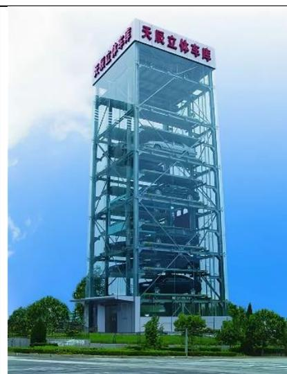
Рисунок 5. Парковка башенного типа
