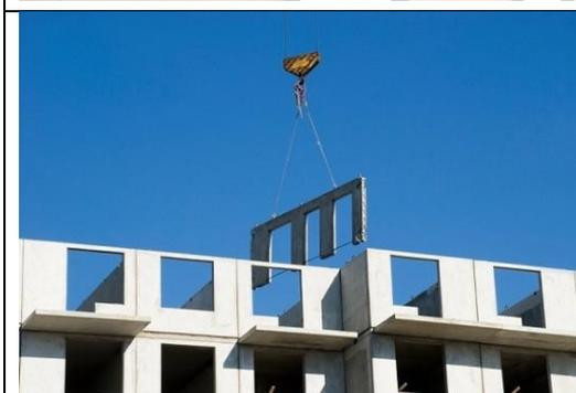
Рисунок 5. Железобетонные стеновые наружные плиты
