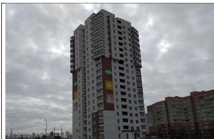
Рисунок 3. Энергосберегающий дом. Минск, по адресу ул. Пташука, 1
