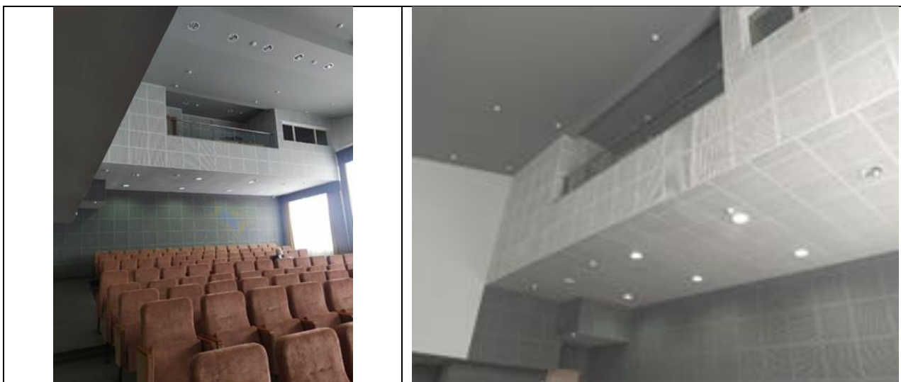
Рисунок 7. Стена, обработанная акустическим материалом
