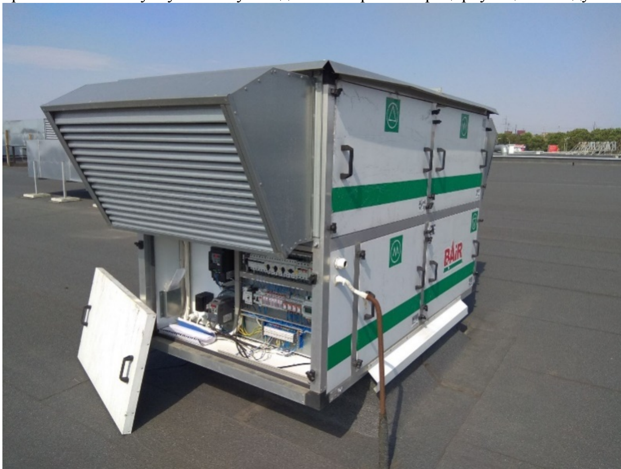
Рисунок 1 – Приточно-вытяжная установка с водяным нагревом и рециркуляцией воздуха
