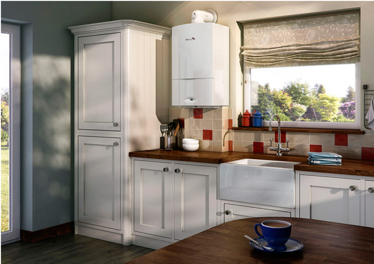
Рисунок 1 – Настенный газовый котел с коаксиальным дымоходом, размещенный в кухонном помещении
