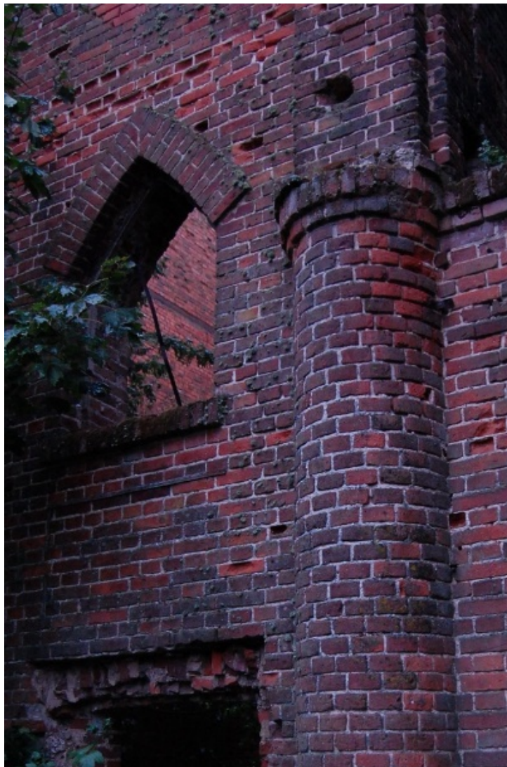
Рисунок 2 – Постройка, оказавшаяся в зоне работ.
