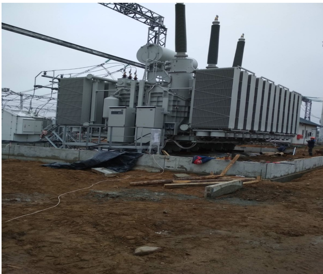
Рисунок 1 – Управляемый шунтирующий реактор типа РТДУ 330/180000-У1
