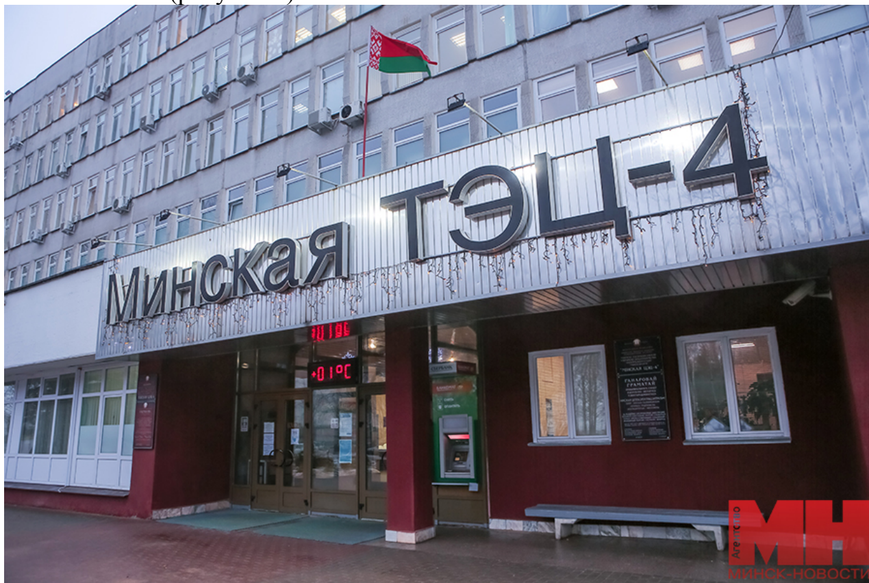
Рисунок 1 – Главный вход в Минская ТЭЦ-4
