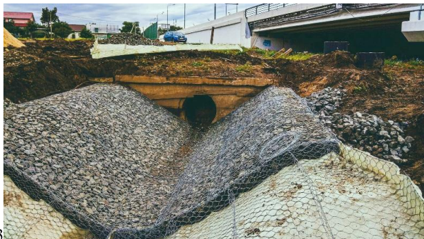
Рис. 7. Укрепление дна и стенок кювета при помощи габионных конструкций
