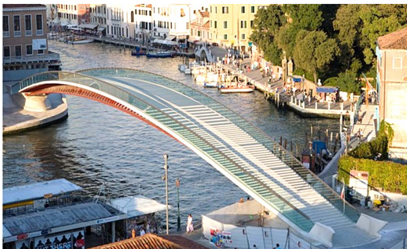
Рисунок 3 – Общий вид сооружения
