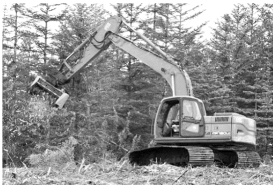
Рис.8. Рабочий орган – мульчер, смонтированный на одноковшовом экскаваторе
