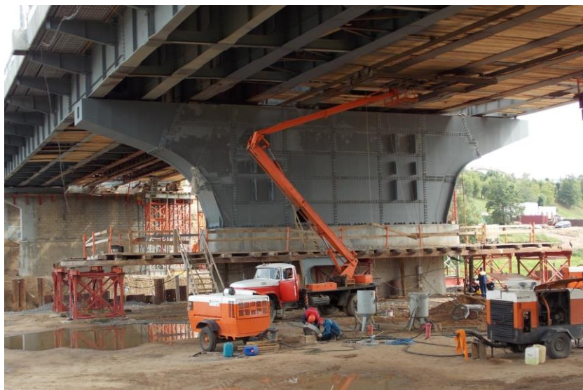
Рис. 6. Вид на металлическую обстройку опоры №4. 17.05.2016
