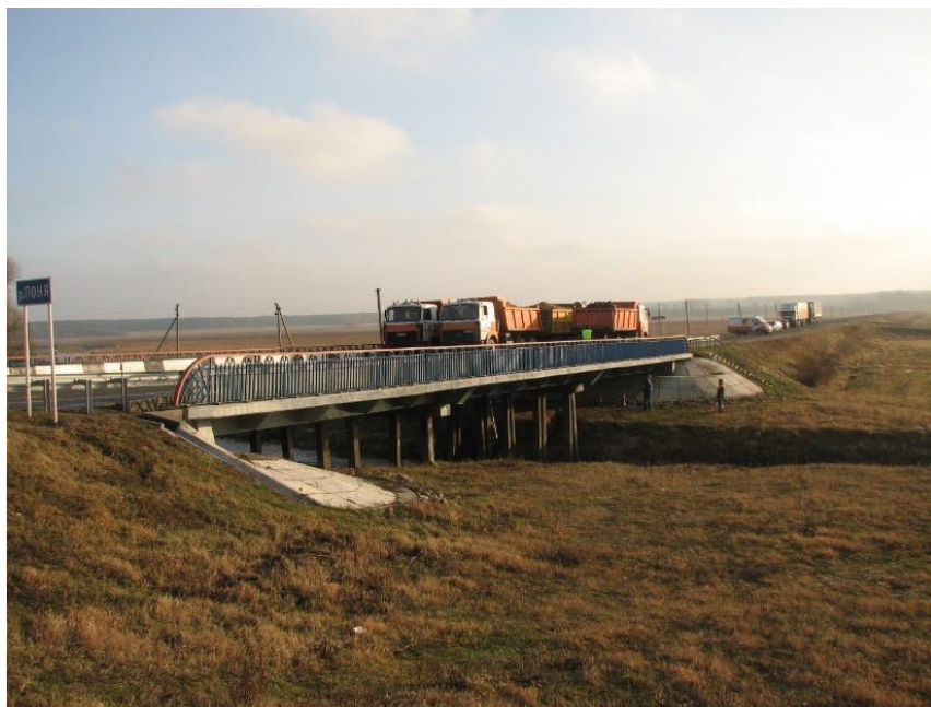
Рис. 4. Установка испытательной нагрузки
