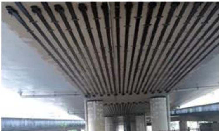
Рис. 2. Мост с применением полимерных композитных пластмасс
