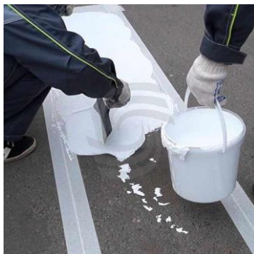
Рис. 6. Нанесение дорожной разметки холодным способом
