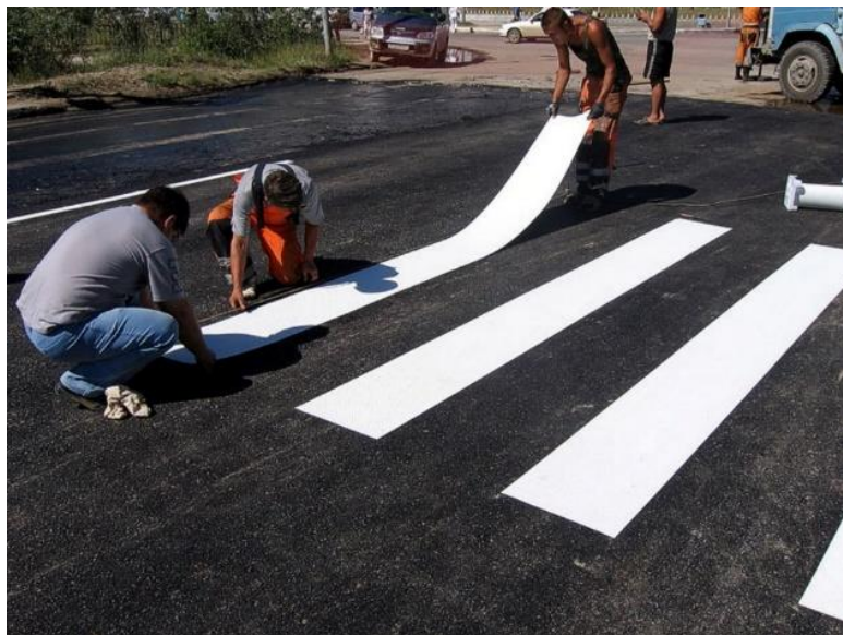
Рис. 8. Нанесение холодного пластика
