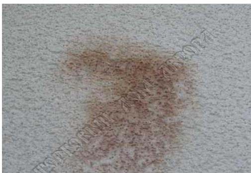
Рис. 5. Макроструктура фрагмента фасада с минеральной плитой и декоративным окрасочным слоем (г. Минск ул. Казимировская, 15)
