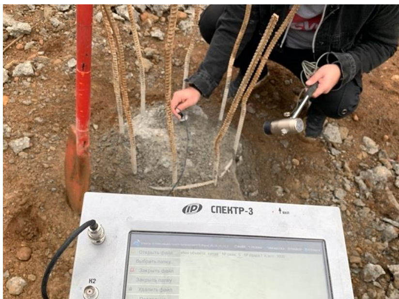
Рис. 2. Установка сенсора-акселерометра на сваю
