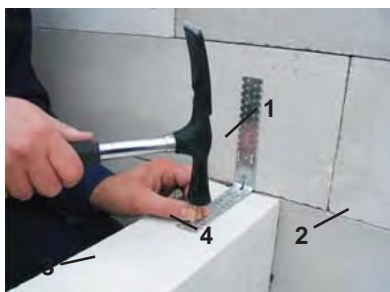
Рисунок 6.4 – Соединение перегородок к несущей стене с помощью соединительных элементов типа «L»
