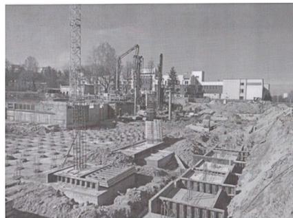
Рис. 5.6. Устройство свай на объекте: «Корпус хирургии и трансплантологии по улице Семашко в Минске»: а – начало производства работ; б – окончание работ нулевого цикла
