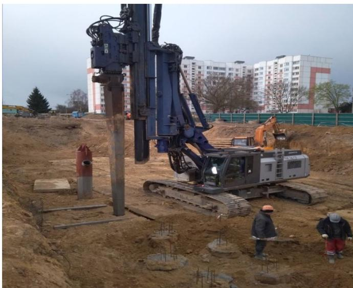
*Рис. 5.18.* Работа буровой установки ABI TM 14/17 при устройстве конических вибронабивных свай
