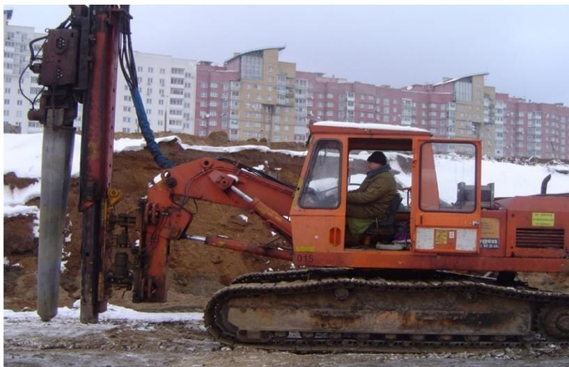
Рис. 1.17. Буровая установка ABI RE10000 с вибропогружателем VRZ 450 на строительстве жилого дома в г. Минске
