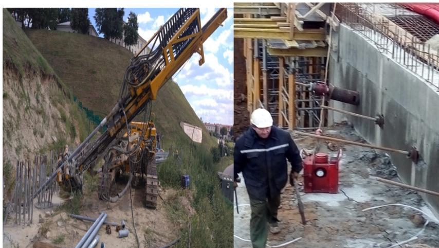
*Рис. 5.24. Устройство анкеров типа TITAN*
