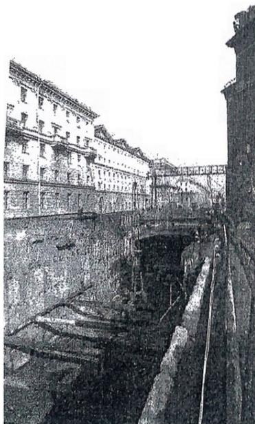
*Рис. 5.21.* Анкерное крепление стен котлована станции метро «Купаловская»
