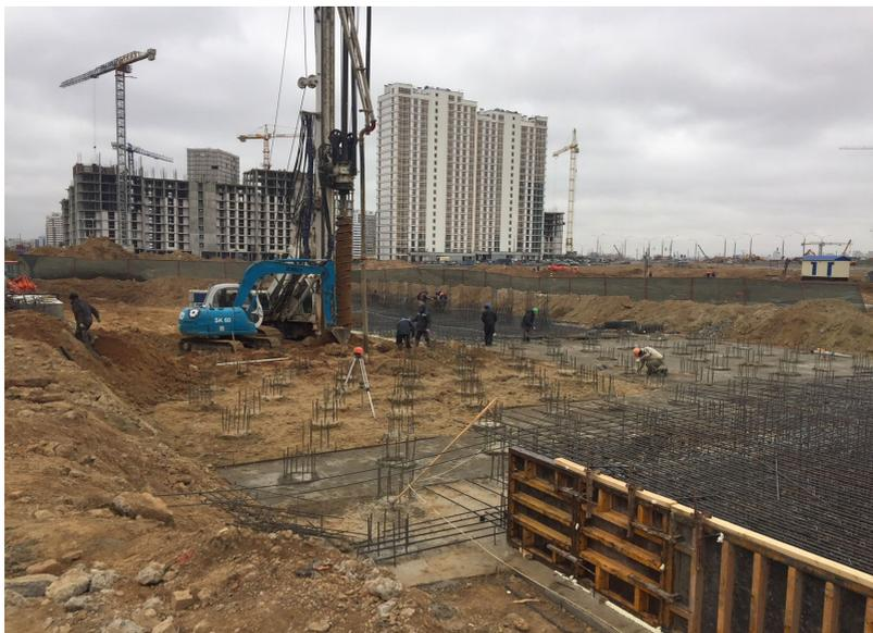
*Рис. 5.20.* Работа буровой установки MDT CMV TH16 по технологии CFA на объекте «Жилой дом 10–10а по г.п. в жилом комплексе «Минск–Мир»
