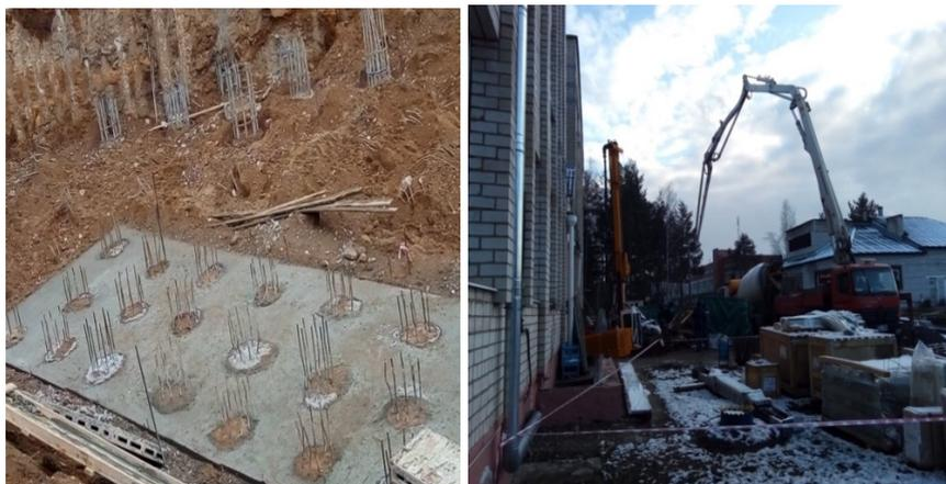
*Рис. 5.19.* Работа малогабаритной буровой установки TRIVE 4 по технологии СФА на объекте «Многофункциональный комплекс на пересечении пр. Независимости и ул. Макаенка в Минске»
