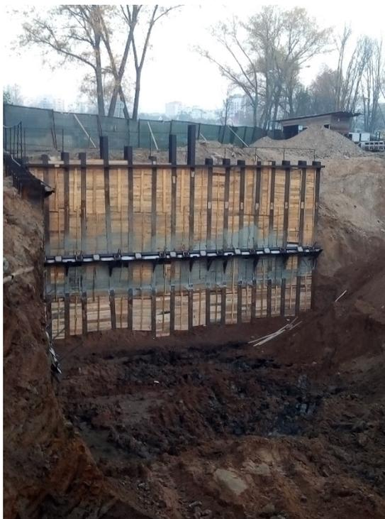
*Рис. 5.27.* Свайно-балочное ограждение котлована при строительстве путепровода по улице Бобруская в г. Минске
