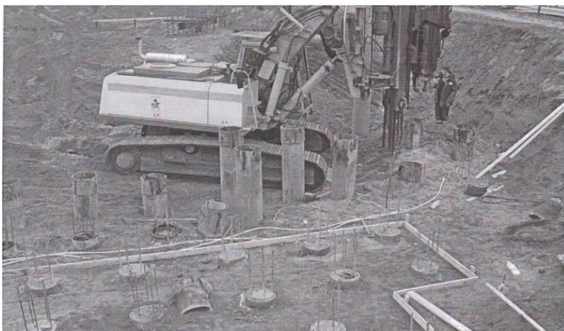
*Рис. 5.16. Устройство вибронабивных свай на объекте «Усадьба Ваньковичей в Минске»*
