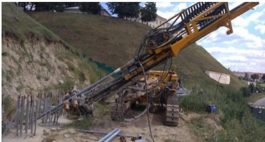
*Рис. 1.21.* Буровая установка KLEMM 806D при устройстве анкеров типа TITAN в Гродно
