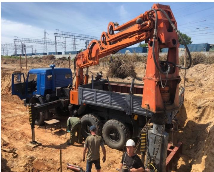
*Рис. 1.34.* Монтаж грузовой платформы установкой БКМ для статических испытаний свай
