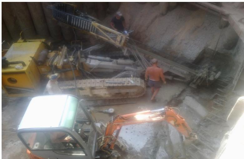
*Рис. 5.31.* Изготовление отсечного наклонного экрана из буроинъекционных свай
