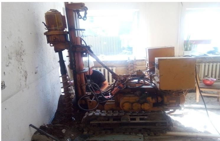
*Рис. 5.33.* Работа бурового малогабаритного станка при упрочнении оснований фундаментов здания по улице Замковой в г. Минске
