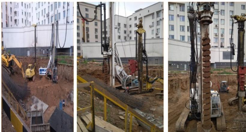
*Рис. 5.13.* Работа буровых установок при устройстве свай по технологии полого шнека
