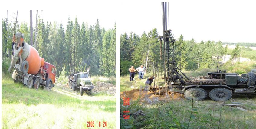
*Рис. 5.4. Устройство свай на природной отметке склона под опору кресельного подъемника*
