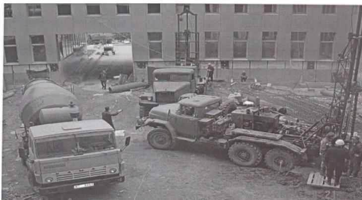
*Рис. 5.1.* Работа автомобильных буровых установок при строительстве Национальной библиотеки
