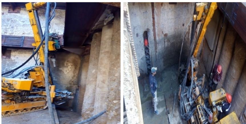
Рис. 5.26. Работа буровой установки при устройстве свай по технологии JET
