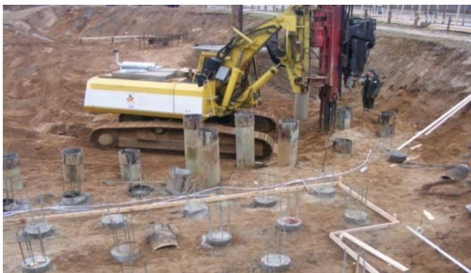
*Рис. 1.16.* Буровая установка ABI RE 12/14300 с вибропогружателем VRZ 700 на строительстве офисного здания в г. Минске
