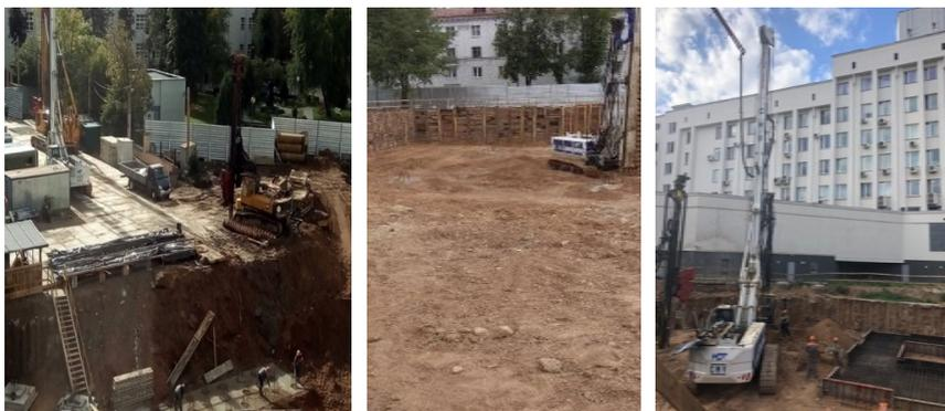
Рис. 5.10. Ограждение котлована инженерного корпуса – шпунтовая стена с забиркой из бревен, ограждающая стена из секущих и соприкасающихся свай
