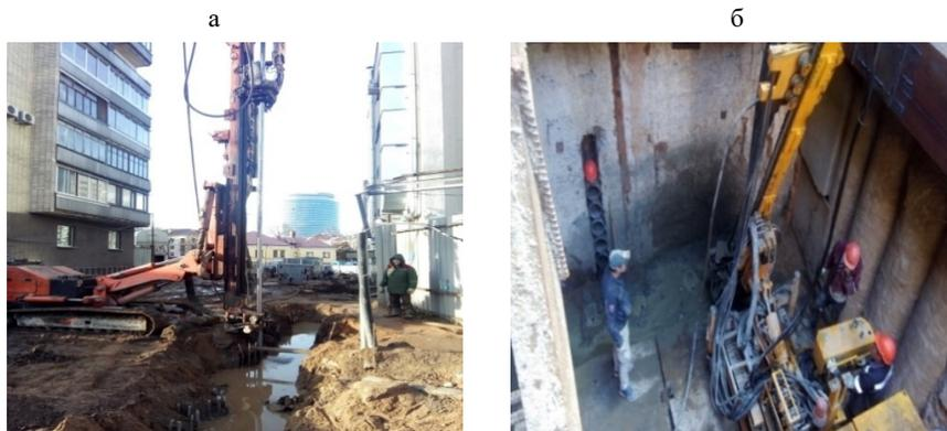
*Рис. 1.19.* Оборудование на объектах строительства Минского метрополитена: а – буровые установки MDT; б – буровые установки KLEMM с инъекционной станцией и смесительным оборудованием METAX
