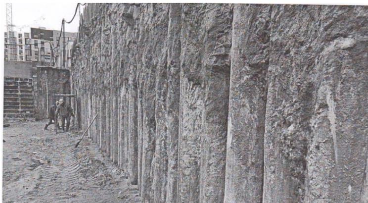
*Рис. 5.14.* Несущая и ограждающая стена котлована при строительстве жилого дома
