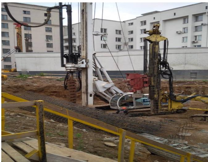
*Рис. 1.8.* Буровая установка MDT CMV TH16 при строительстве инженерного корпуса дирекции Минского метрополитена
