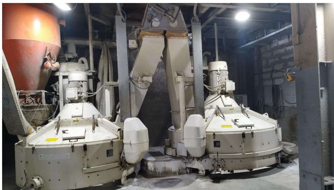
Рисунок 2 – Смесительный цех завода Метрострой
