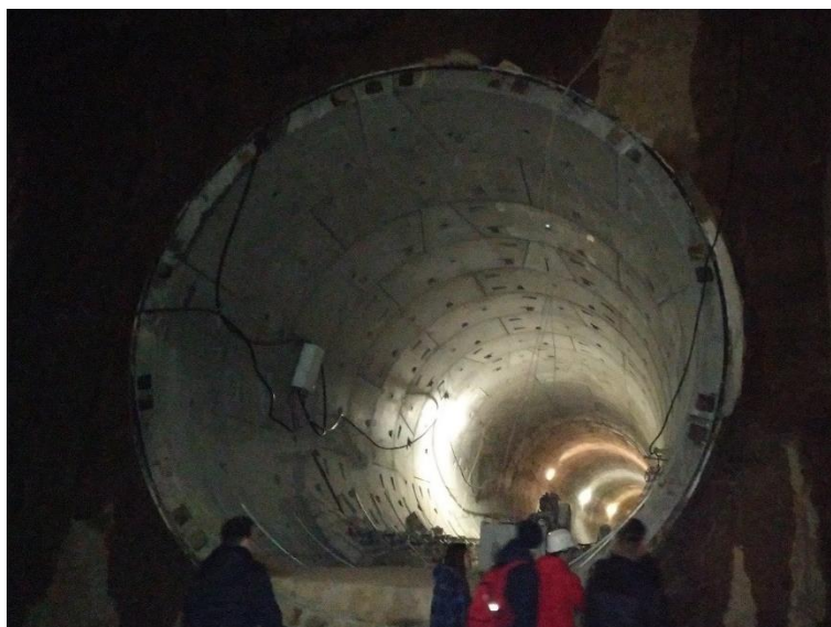
Рисунок 1 – Участок тоннеля 3 ветки Минского метрополитена
