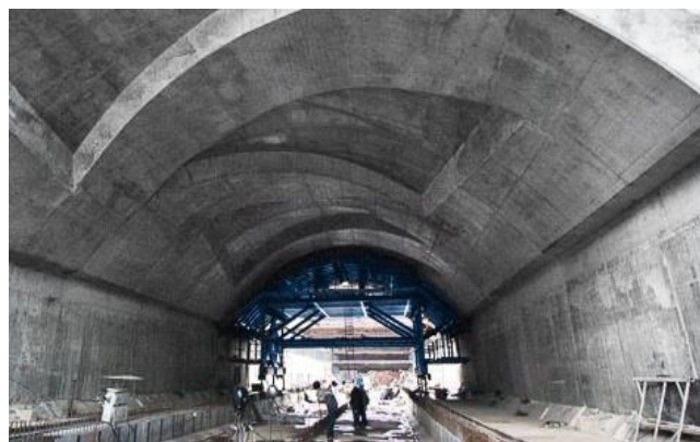
Рисунок 2 – Механизированный опалубочный комплекс СТАЛФОРМ Инт
