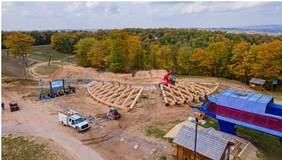
Рисунок 3 – Строительство деревянных башен
