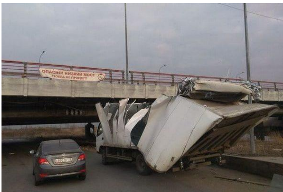
Рисунок 1 – Авария под софийским путепроводом
