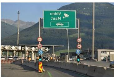
**D.** E-Maut-Systeme verringern die Staubildung, indem sie Mautkosten automatisch anhand von Kennzeichenerkennungs- und Fahrzeugtrackingtechnik erheben, ohne dass Fahrzeuge anhalten oder langsamer fahren müssen [2].
