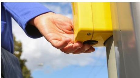
**Weitere Merkmale.** Am Ampelmast ist ungefähr in Höhe eines Türgriffes der sogenannte "Anforderungskasten" angebracht. Dieser ungefähr handgroße Kasten ist eckig, abgerundet oder fast halbkugelförmig. An seiner Unterseite befindet sich der Taster zur Anforderung des „Freigabesignals“. Dieser Taster vibriert bei Grün.
