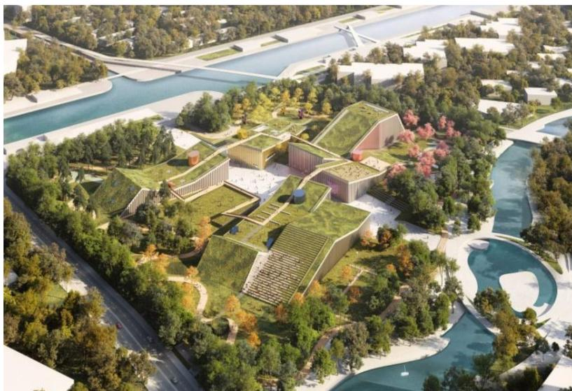
Рис. 4.13. Здания с озелененными крышами в парке высоких технологий «Чжанцзян» повторяют формы естественного холмистого ландшафта, г. Шанхай (Китай)
