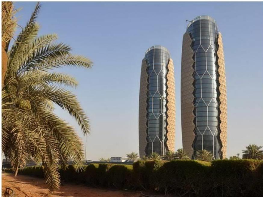
Рис. 2.7. Небоскребы Al Bahar Towers в Абу-Даби (ОАЭ) имеют фасады, которые защищают здания от солнечного перегрева за счет открытия или закрытия навесных трансформируемых конструкций, архитектор Э. Оборн
