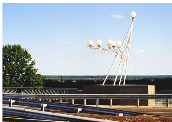
Рис. 14. Обход г. Бобруйска, 2001 г. Въезд на мост через Березину. Арх. А.С. Сардаров
