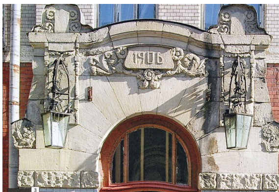
Рис. 4. Санкт-Петербург. 1905–1906 гг. Вход в здание школы. Арх. А. Ф. Бубырь
