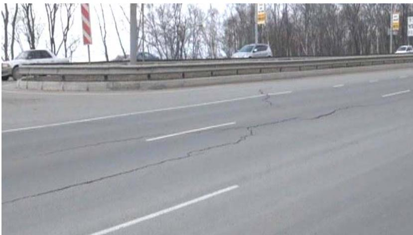
Рис. ПЗ0. Продольные трещины с колесей до 30 мм
