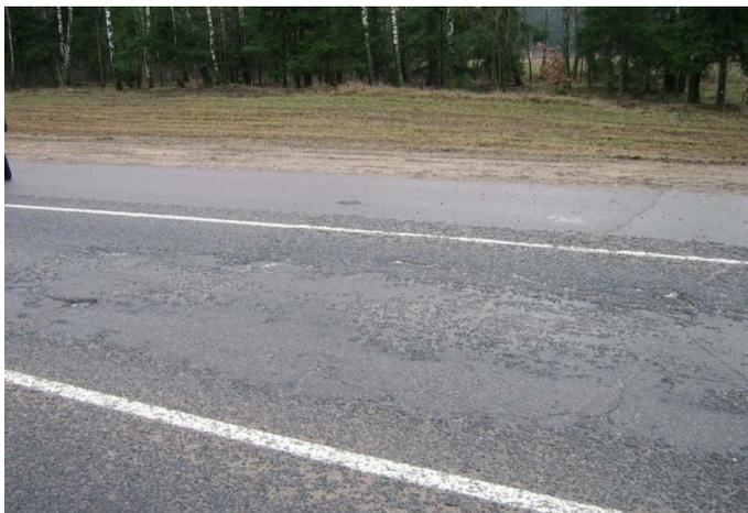
Рис. П35. Разрушение защитного слоя покрытия
