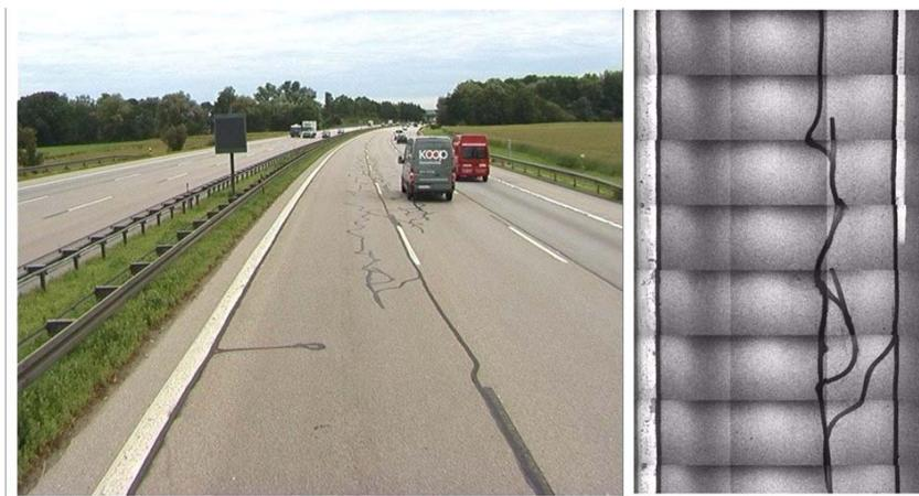
Рис. П20. Отраженные продольные и поперечные трещины
