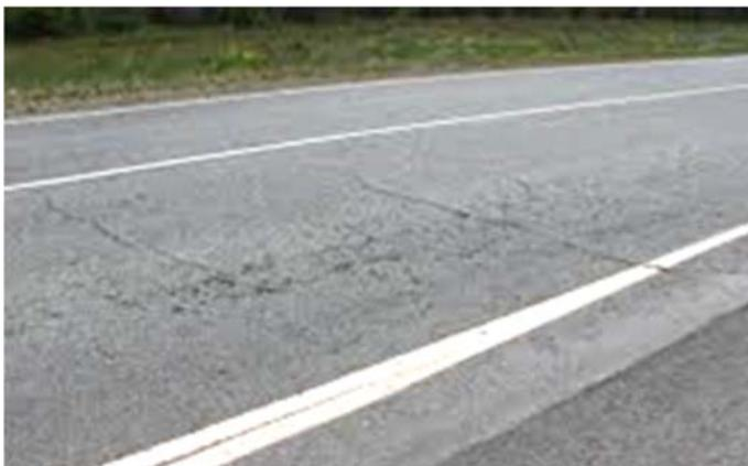
Рис. П24. Шелушение, одиночные трещины на покрытии
