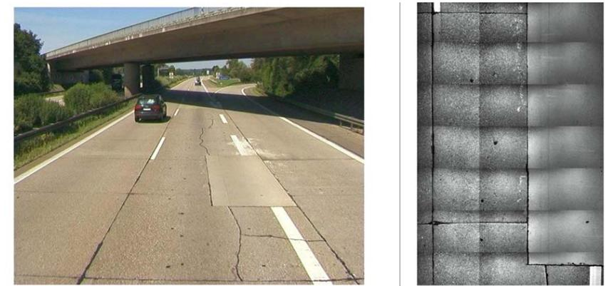
Рис. П23. Усталостные трещины с шириной раскрытия более 5 мм
