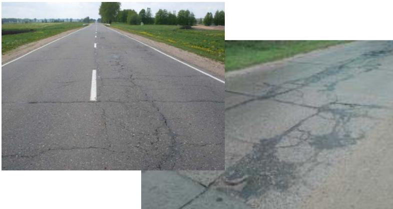
Рис. П29. Частые трещины с выкрашиванием
