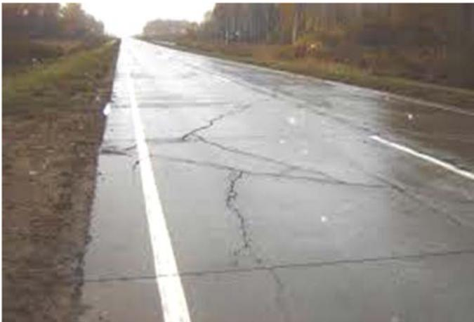
Рис. П32. Трещины цементобетонного покрытия
