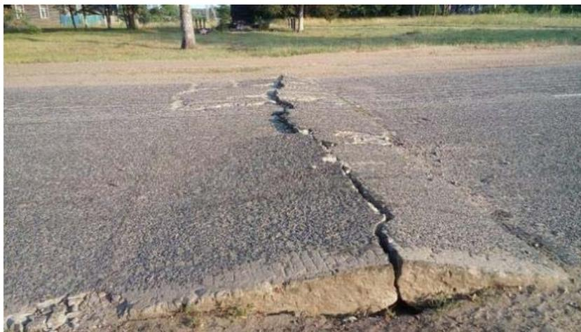
Рис. ПЗ4. Нарушение целостности плит, подъем плиты
