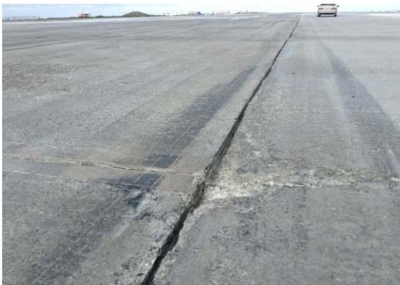
Рис. ПЗ3. Разрушение шва и сопряженного покрытия
