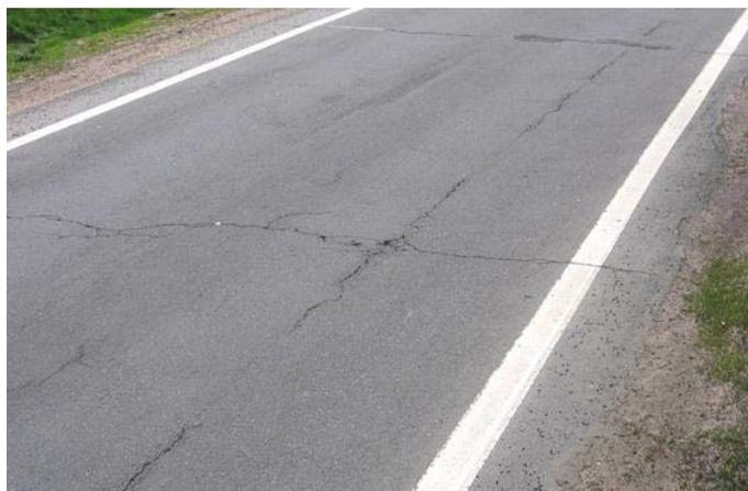
Рис. П27. Колея на покрытии до 30 мм с дефектами
