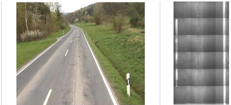
Рис. П21. Силовые трещины, с сеткой трещин
