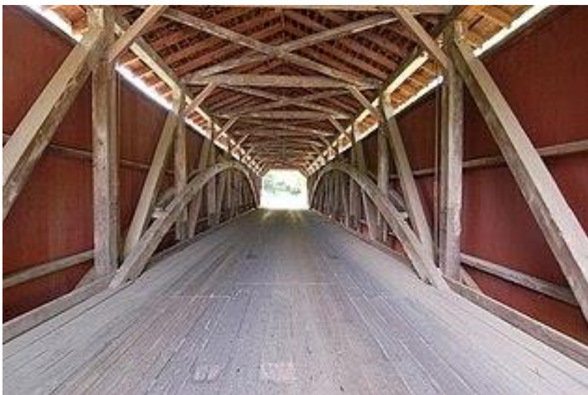
Рисунок 2 – Конструкция крытого деревянного моста изнутри
