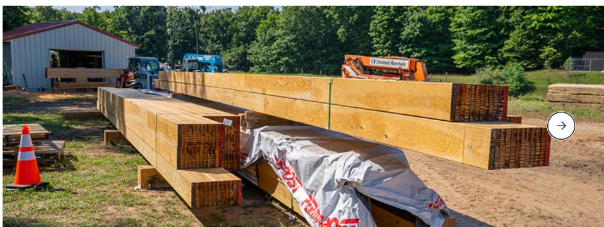
Рисунок 3 – Клееный брус с внутренним креплением
