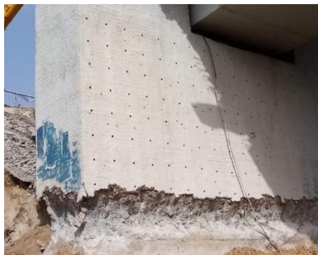
Рисунок 2 – установка зарядов
