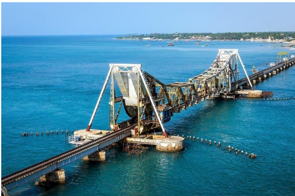
Рисунок 1 – Подвижный подъемный мост Pamban Bridge
