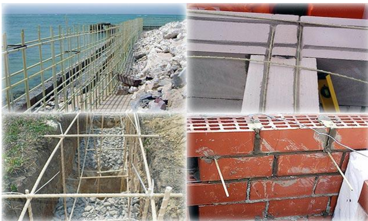
Рисунок 1 – Неметаллическая арматура
