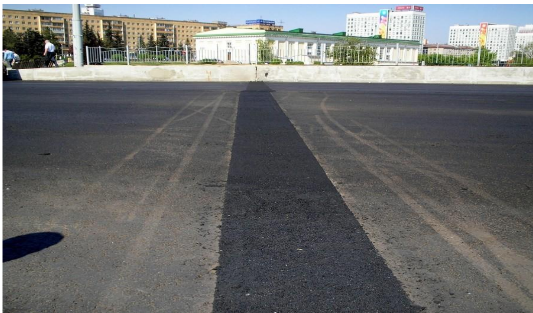
Рисунок 1 – Деформационный шов закрытого типа
