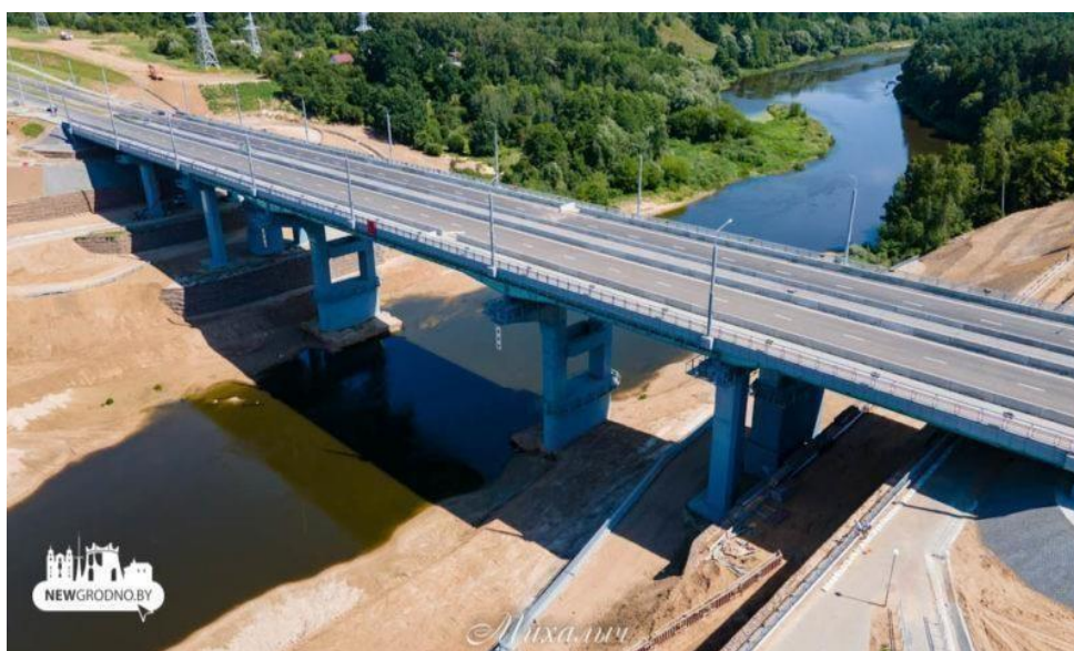
Рисунок 3 – Мост Восточный после реконструкции
