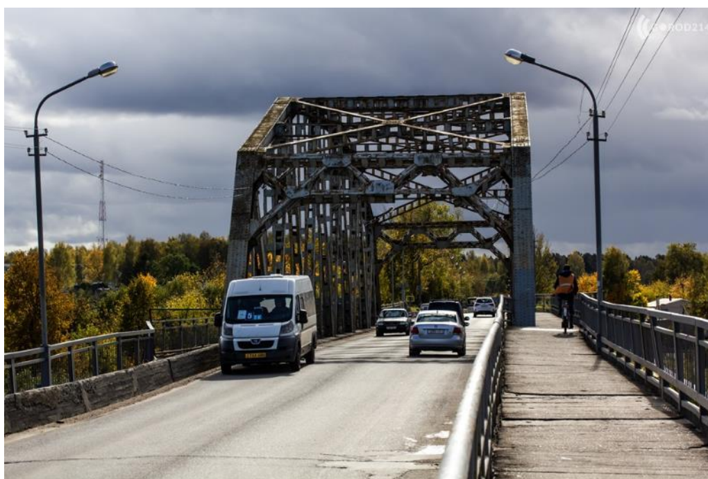
Рисунок 4 – Мост до реконструкции
