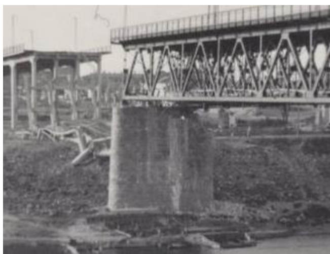
Рисунок 1 – Фрагмент моста 1941г
