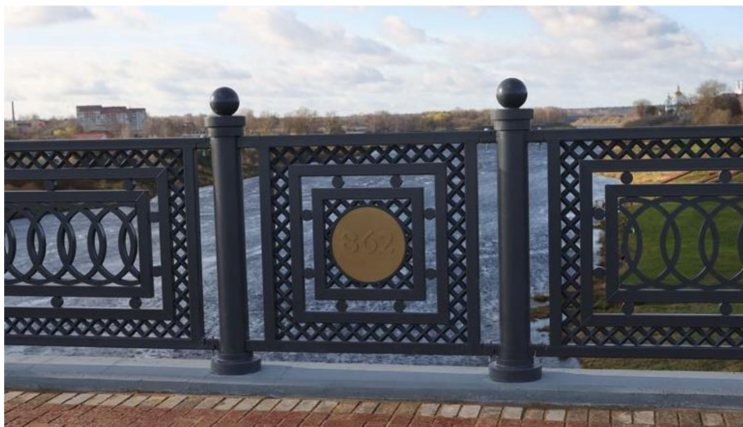
Рисунок 3 – Перильное ограждение
