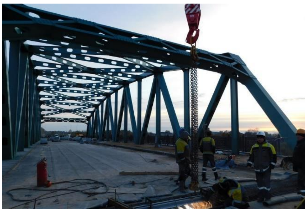
Рисунок 2 – Монтаж ферменного пролёта
