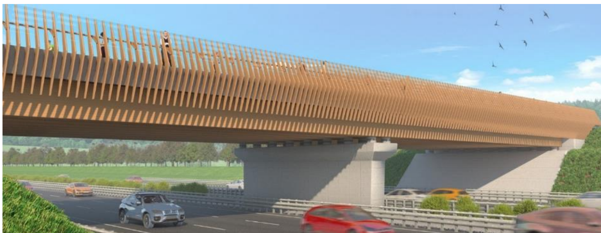
Рисунок 1 – Деревянная надстройка кругового моста в Нидерландах
