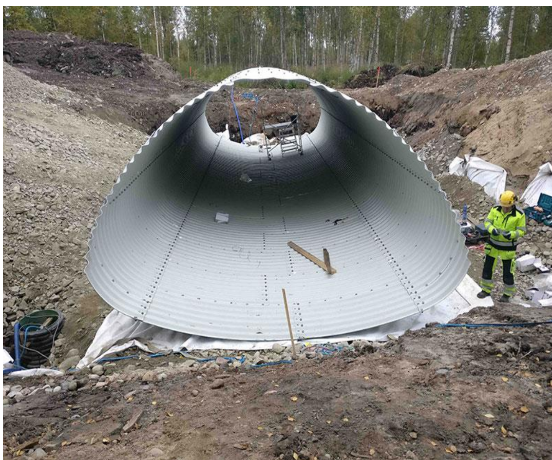
Рисунок 3 – Конструкция скотопрогона
