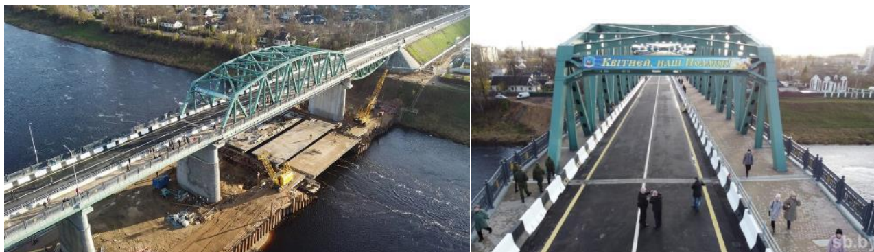
Рисунок 5 – Внешний вид моста после реконструкции
