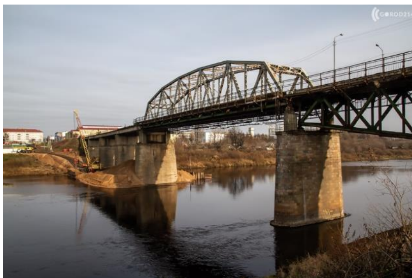
Рисунок 4 – Внешний вид моста до реконструкции
