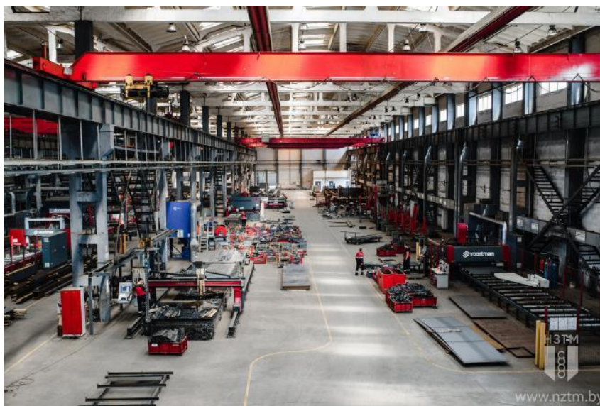
Рисунок 2 – Общий вид сборочной линии
