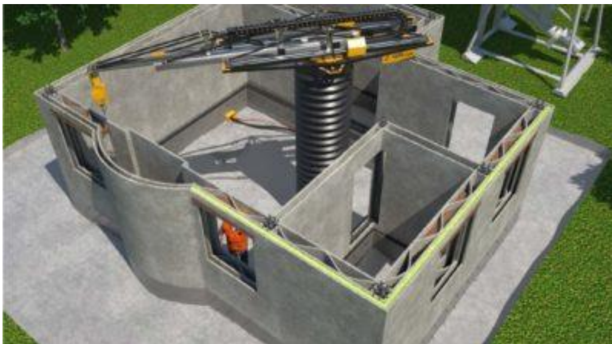
Рисунок 1 – Процесс печати сооружения
