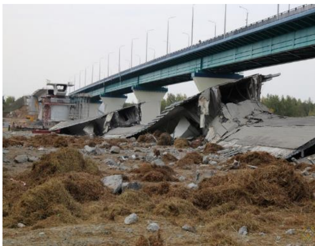
Рисунок 1 – сооружение после демонтажа
