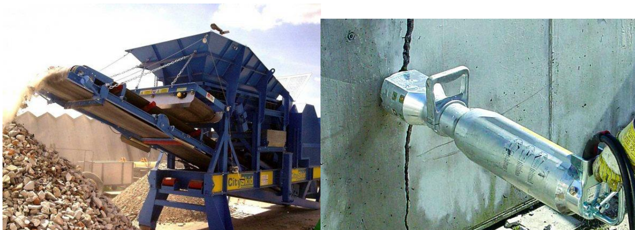
Рисунок 1 – Демонтаж и переработка бетонных и железобетонных конструкций
