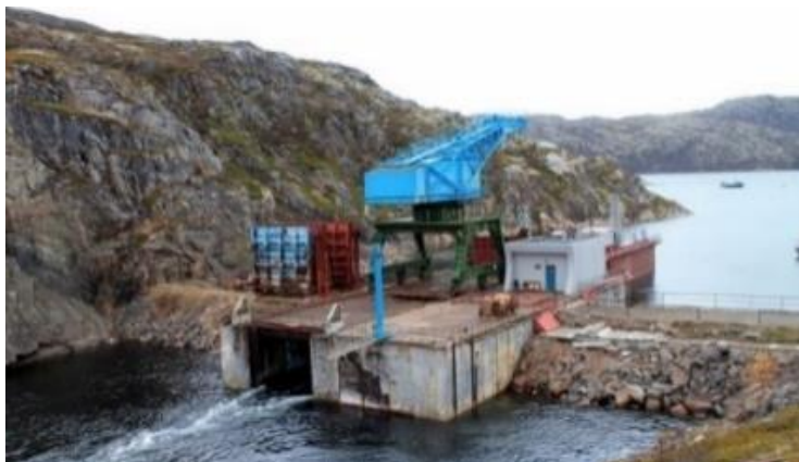
Рис. 1. Кислогубская приливная электростанция (ПЭС)
