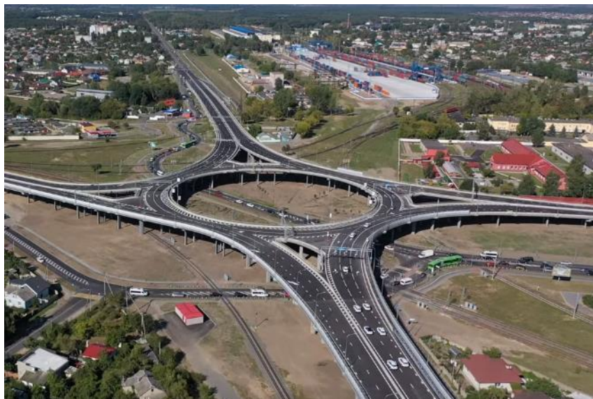
Рисунок 2 – Путепровод «Западный обход»
