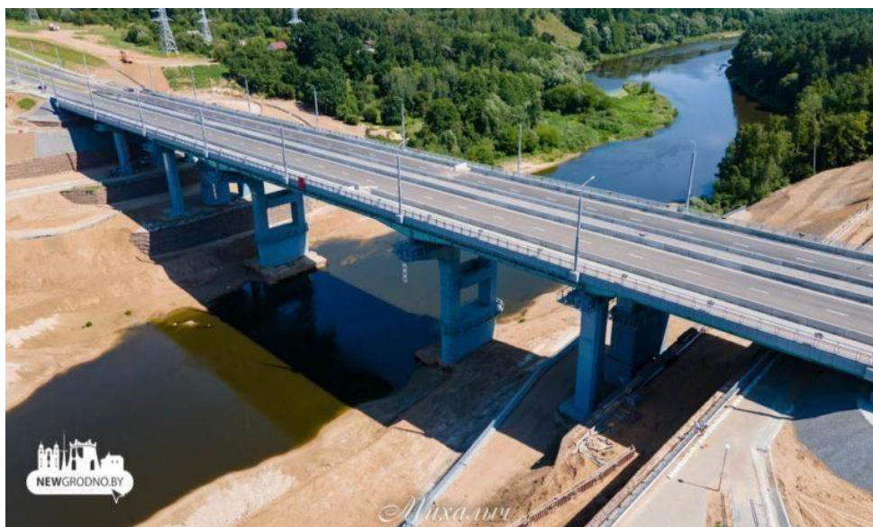
Рисунок 3 – Мост Восточный после реконструкции
