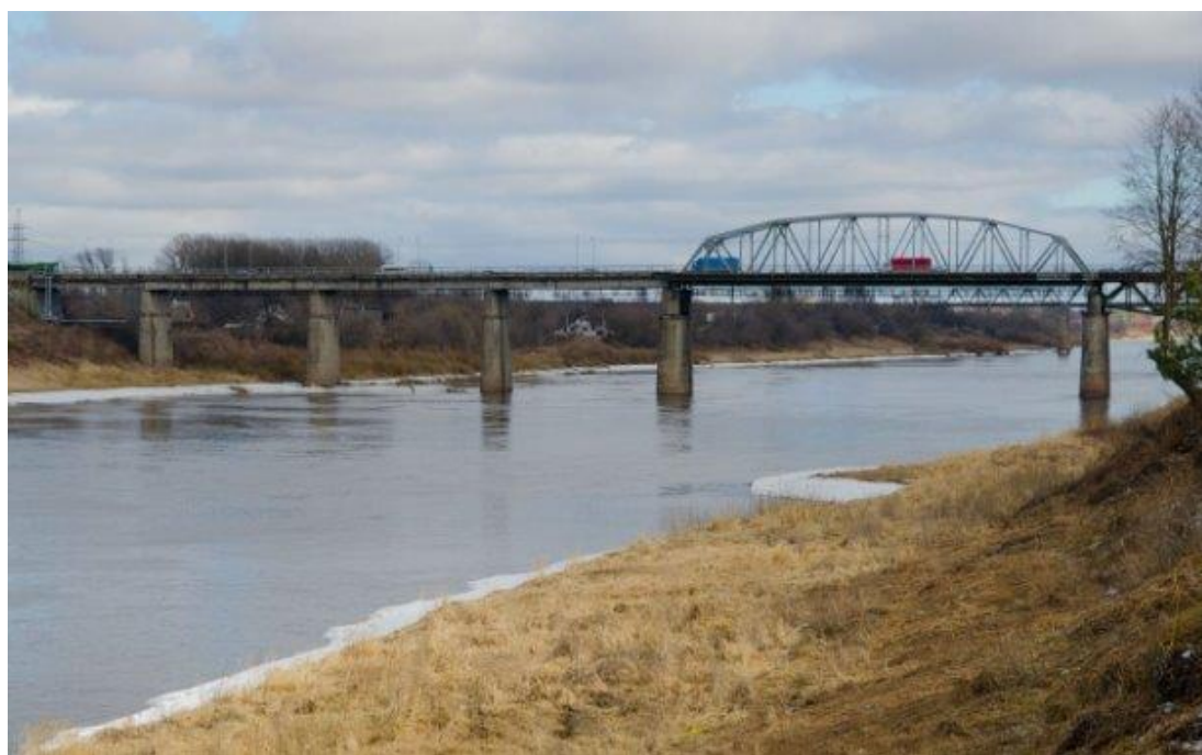
Рисунок 1 – Мост через Западную Двину в Полоцке, 2014 г
