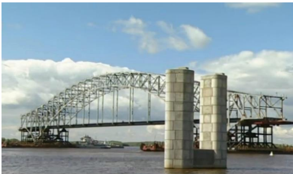
Рисунок 1 – Переправа по реке центрального пролетного строения моста «Красный Дракон»
