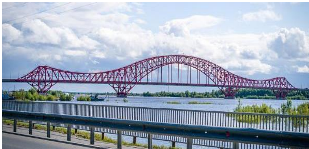
Рисунок 2 – Центральная часть моста «Красный дракон»
