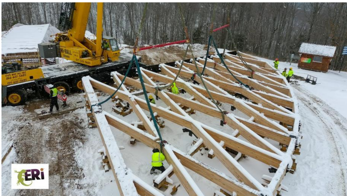
Рисунок 4 – Монтаж деревянных башен
