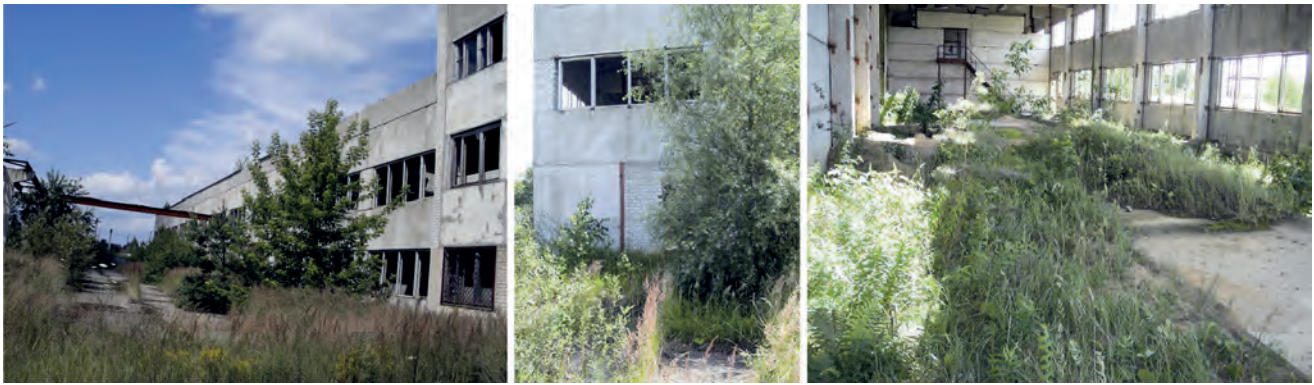
Рис. 1. Корпус механических мастерских до начала реконструкции (22.07.2010 г.)
