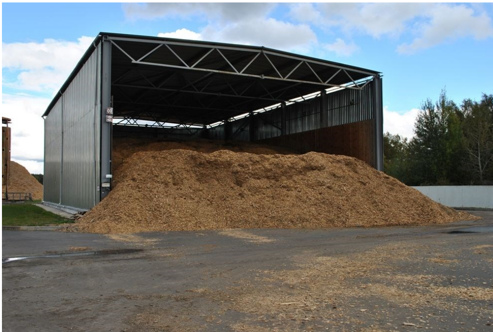
Рисунок 2 - Топливный склад МВТ
