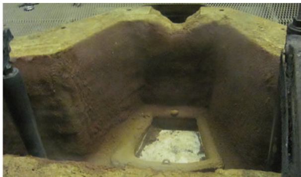
Общий вид промежуточного ковша с установленным металлоприемником
